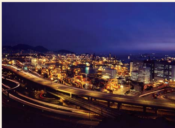
葵涌貨櫃港（攝於2003年）
