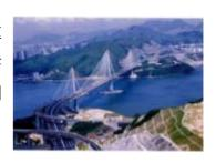
斜拉橋橋面是由連接在橋塔上的鋼索張拉支撐。這種橋樑的結構,是介乎吊索橋與樑式橋之間,優點是橋墩比樑式橋少,但又不需要吊索橋沉重的上懸索,工程較吊索橋簡單,造價亦較便宜。以往的斜拉橋均是雙橋塔式設計,但由於藍巴勒海峽海面有近一千米闊,興建雙塔式斜拉橋跨度太大,工程費用會十分高昂,當局只有選擇三塔式設計。三塔式設計要克服工程上的困難,特別是中央塔的受力問題,而吊索的數量亦較多,對於工程人員是一項很大的挑戰。
