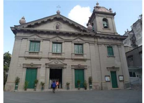
教堂的高約 15 米鐘樓為三層，高約 22 米，位於大堂右側，形成不對稱佈置。大堂平面為長方形，側有一祈禱室。堂內祭壇為建於 1875 年的巴洛克式聖壇，採用斷山花和雙柱的形式，中間有耶穌釘在十字架上的塑像，上面有耶穌會標志 IHS。堂內還有多個祈禱室，裝飾精巧，並有壁柱。建築的彩色玻璃窗上為幾何圖案。建築細部與裝飾主要為新古典式，但內部聖壇有巴洛克特點。建築外觀為 1930 年年改建成的水刷石粉面，是西方古典風格。室內採用磚木結構，橢圓形木構拱頂，木屋架上為坡屋頂，瓦屋面。夾層樓板為鋼筋混凝土結構。
