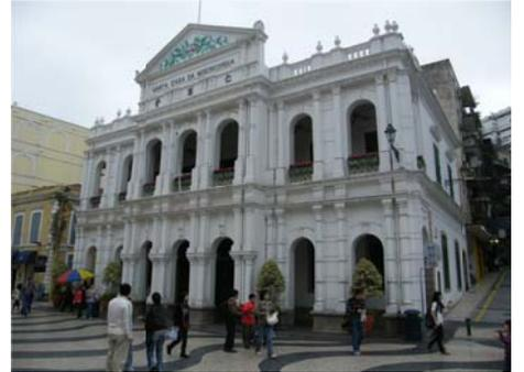
現在的仁慈堂是一座兩層磚石建築，其立面具有新古典建築特色。立面寬 20 米，女兒牆高度為 12.5 米，頂上三角山花高 16 米。除花崗岩基座外，整個建築粉刷成白色，正立面券柱式構圖，中軸對稱，共七開間，中間三開間較大並略突出，三角形山花內有白色淺浮雕。數十年前，山花上曾置有創辦人卡內羅的半身像，現放在博物館入口。立面柱子成對布置，柱子多變，均立於基座上。二層遊廊欄板和屋頂女兒牆做成鏤空狀，立面線條豐富，整個建築顯得很精緻，是美麗的西方古典建築之一。
