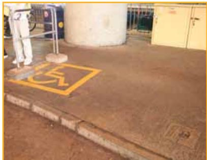
巴士站月台亦有類似情況發生，圖中兩巴士站均設有輪椅上落車位置，左邊設有下斜路緣，方便輪椅人士前往輪椅上落車位置。但右邊無下斜路緣，輪椅上落車位置形同空虛設。
