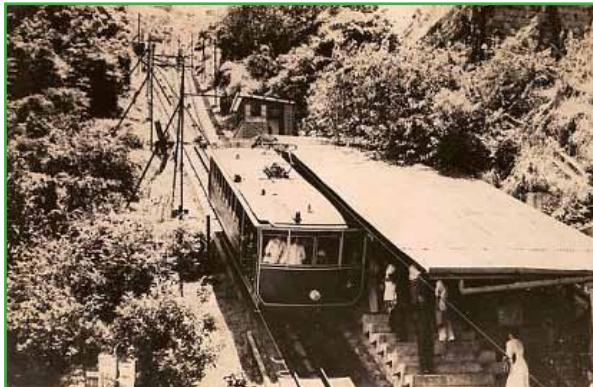
第二代山頂纜車（1926 -1948），電動拖曳齒輪系統取代蒸氣發動，新車廂設有52個座位。
