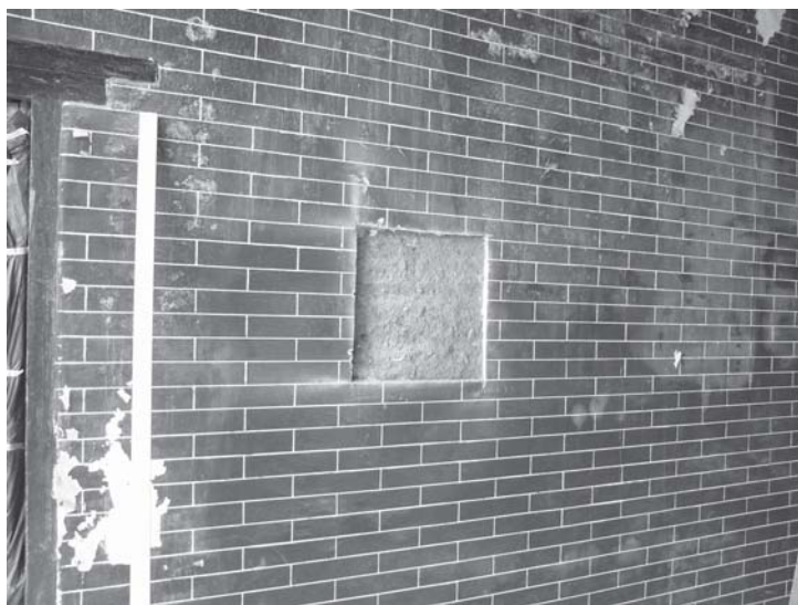
室內間隔以夯土為牆
