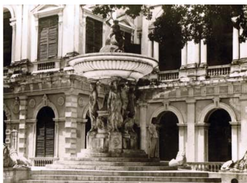
紀念香港供水五周年的噴水池
