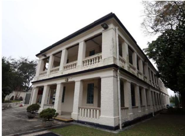
柱均用磚砌，然後髹漆。遊廊由方磚柱支撐，柱基和柱頭線條簡潔。上層遊廊裝有典型的古典甕形扶欄，但地下遊廊的扶欄款式不同。兩層檐口均有線飾。內部間隔與原貌相若。
