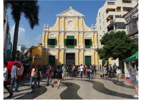
教堂於 17 世紀改為磚木結構，今日規模是 1828 年重建時奠定的。教堂建築面積約 1,300 平方米，正廳為第一層，內有挑廊。平面呈巴西利卡式，有中廳和側廊，兩側還有聖龕，後面為聖壇，室內吊平頂，聖壇裝飾為典型的巴洛克風格，尤以麻花柱最為突出，其餘部分裝飾用古典式線腳。教堂立面總高約 24 米，正面為三層，古典式構圖，底層為愛奧尼柱式，二、三層為科林斯新柱式，三層頂部為三角形山花。建築外牆除基座為花崗石外，柱式與牆面均為黃色粉刷，白色線腳。屋頂為兩坡屋頂，木屋架，瓦屋面，主體為磚木結構，夾層為木樓板。室內柱子為磚砌方柱，外加粉刷。建築富麗堂皇，第三層多明我會會徽居中，顯得莊嚴神聖。外部淺黃色粉刷與白色線腳則表現了葡萄牙建築的特色。教堂是澳門保持早期古典式最美麗的作品。教堂於 1997 年重修，其鐘樓的“聖物寶庫”收藏展示三百種珍貴文物。
