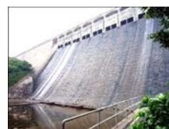
大潭篤水塘水壩為石面混凝土重力壩，長364 米、高49 米、中間位置設有12 條拱型溢洪道。壩底位置設有靜水池及行人橋，而壩頂則築有道路。水壩以層列花崗石砌成築有石面粗琢花崗石裝飾護牆。水壩中間10 條溢洪道加建了混凝土構築物，改為虹吸式溢洪道，其餘兩端的溢洪道則未予改動。
