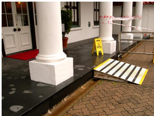
金鐘茶具文物館於門口階級前加設活動式斜坡道
