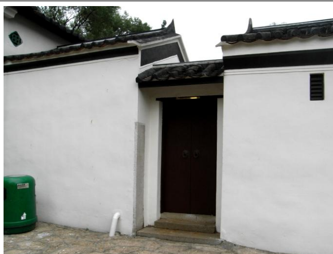
若三棟屋博物館於側門加設活動式斜坡道， 可方便輪椅使用者直接進入展覽廳參觀。
