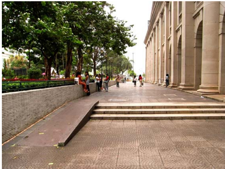
中環皇后像廣場階級附設有輪椅斜坡道
