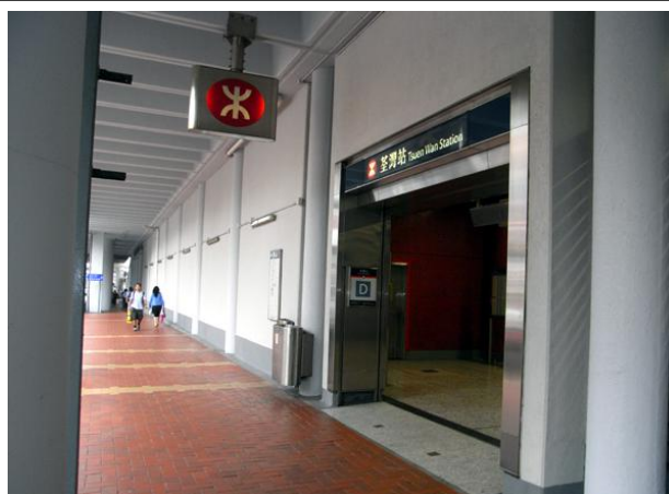
港鐵荃灣站 D 出口平地設計方便輪椅出入
