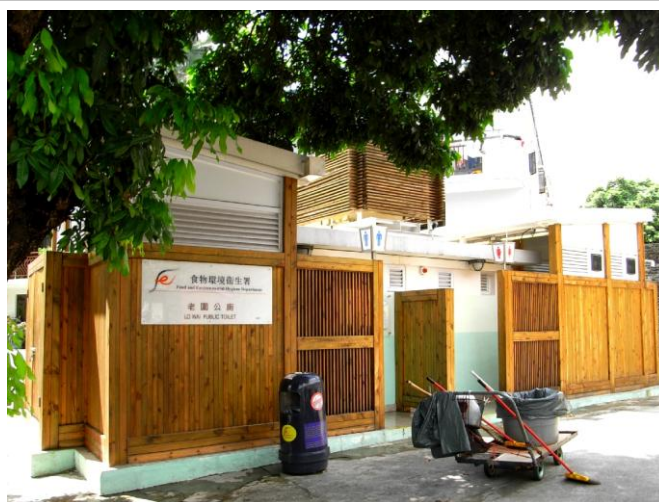
龍躍頭老圍新建公廁，但亦沒有設置傷殘人士公廁。
