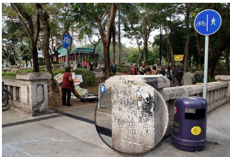
舊有廣福橋的石欄桿、石臺
