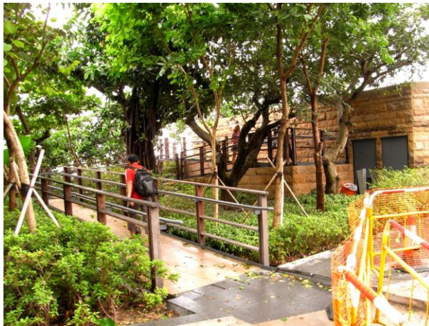
斜坡道亦加設兩旁扶手以減少意外發生
