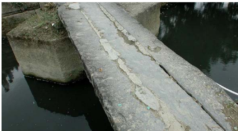
便母橋橋面闊約 1.3 米
