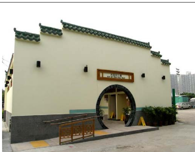
屏山坑尾村新建傷殘人士公廁，設備完善。
