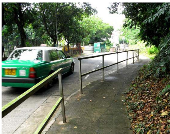
沿途行人路沒有斜坡面供輪椅上落
